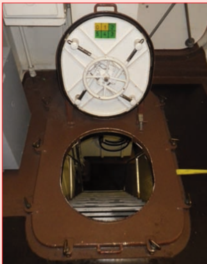
Photo n°11 : échappée avec situation d'étanchéité de niveau 2
