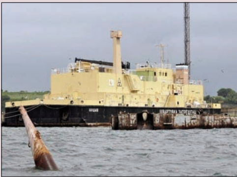
Photo n°14 : Unité de traitement russe.
