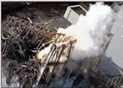
Photo n°9 : Formation d'un panache radioactif.
