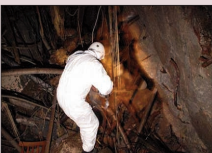
Photo n°11 : Rétablir l'alimentation électrique.
